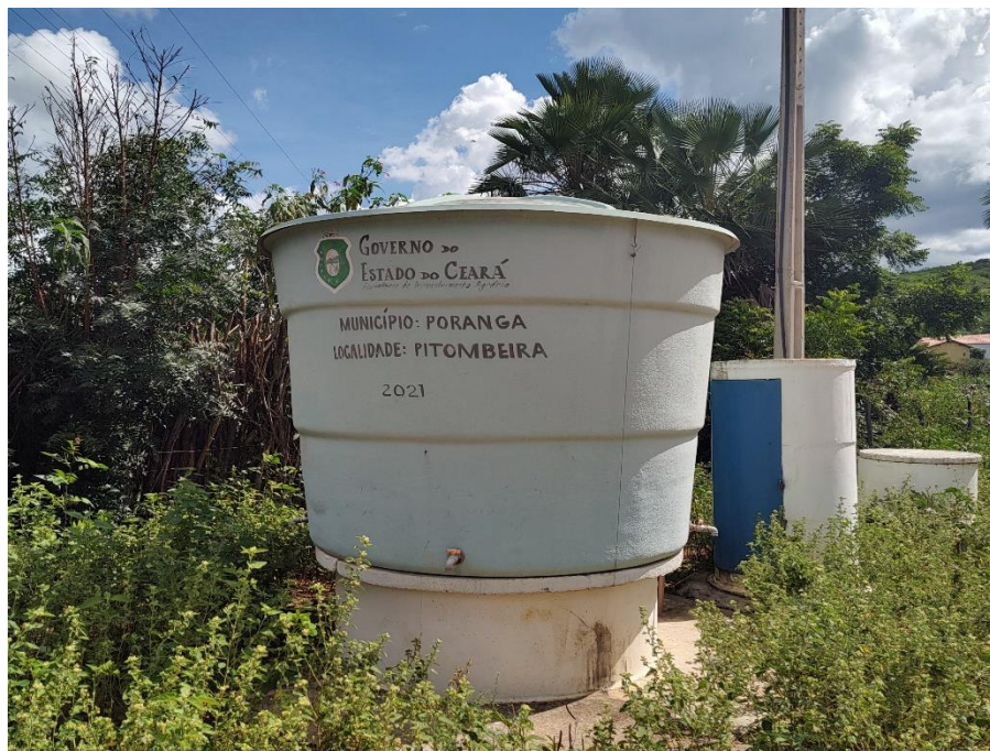
Foto 87: Poço profundo da prefeitura de Poranga, instalado pela Secretaria do Desenvolvimento Agrário do Ceará (SDA), situado na localidade de Pitombeira, município de Poranga. Coordenadas: Este – 254.722 ; Norte – 9.474.954.
