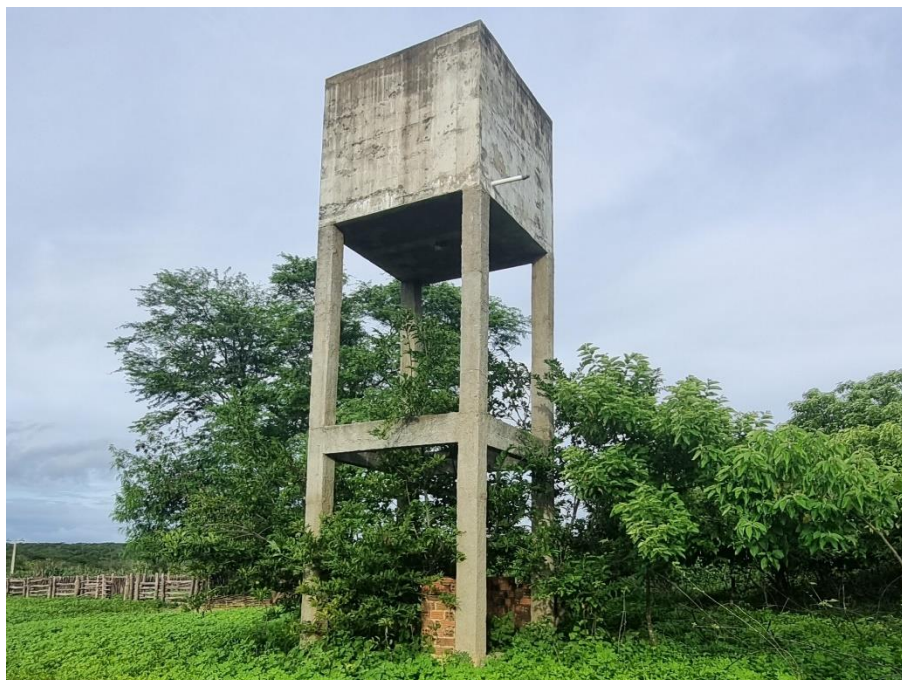
Foto 65: Caixa d'água da prefeitura de Crateús, situada na localidade de Mambira, município de Crateús. Coordenadas: Este – 280.849 ; Norte – 9.435.261.
