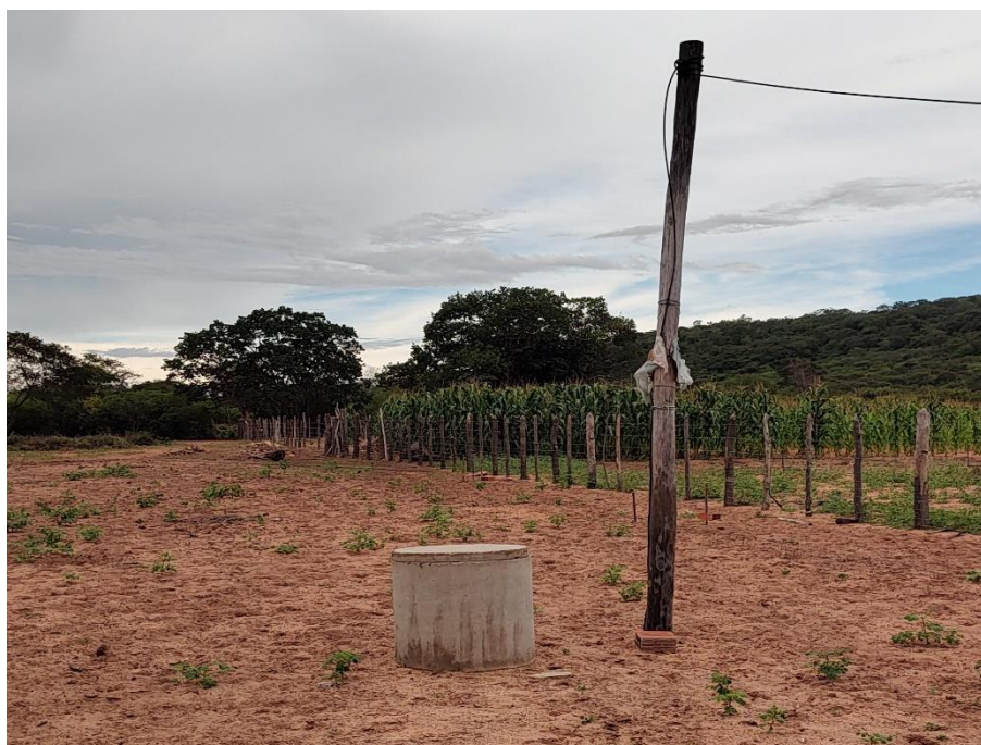
Foto 84: Poço profundo da prefeitura de Poranga, situado na localidade de Falsas Salsas, município de Poranga. Coordenadas: Este – 270.414 ; Norte – 9.487.015.
