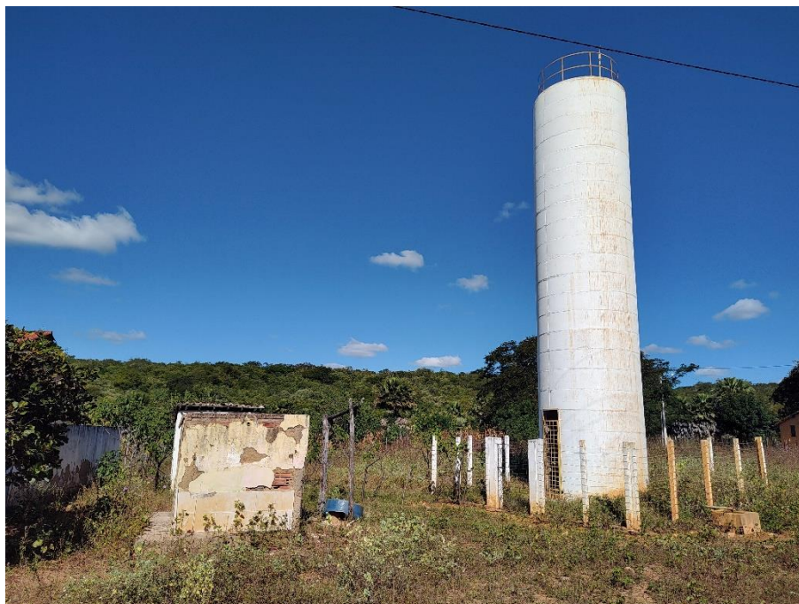
Foto 105: Torre de abastecimento do SISAR, instalada pelo Governo do Ceará, situada na localidade de Barro Vermelho, município de Guaraciaba do Norte. Coordenadas: Este – 268.425 ; Norte – 9.527.912.
