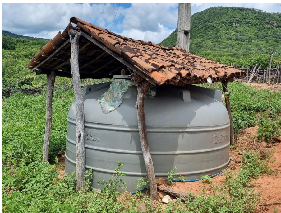
Foto 62: Cisterna do Governo Federal, situada na localidade de Estreito, município de Crateús. Coordenadas: Este – 277.626 ; Norte – 9.442.343.
