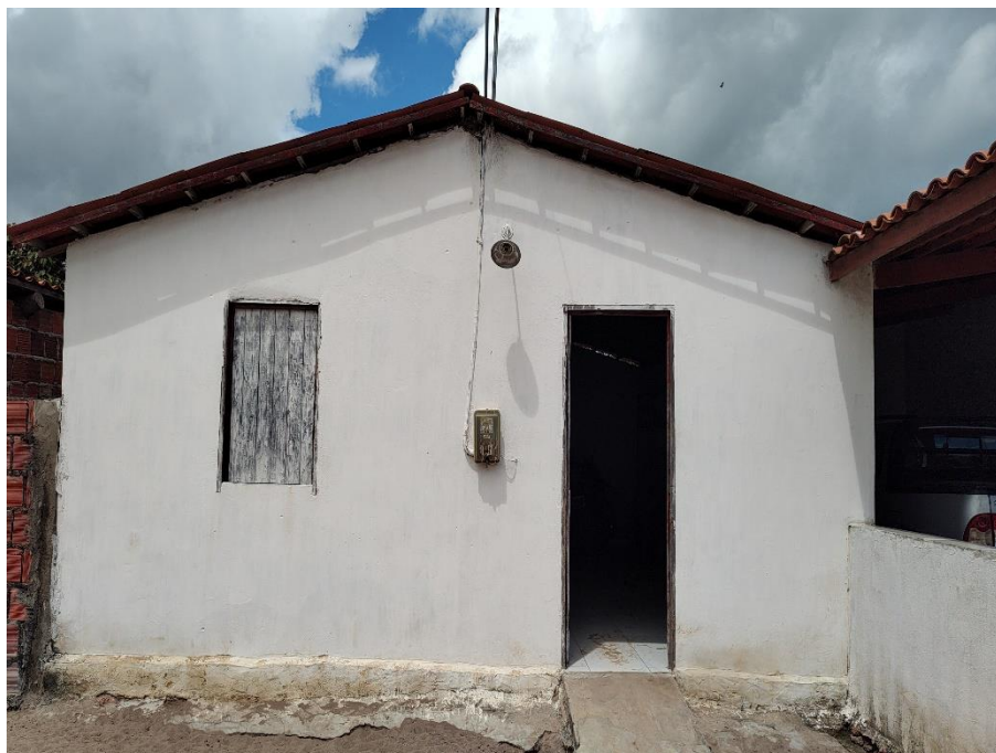
Foto 29: Ponto de Apoio de Saúde, situado na localidade de Pau D'óleo, município de Crateús. Administrado pelo município de Crateús. Coordenadas: Este – 285.440 ; Norte – 9.403.938.
