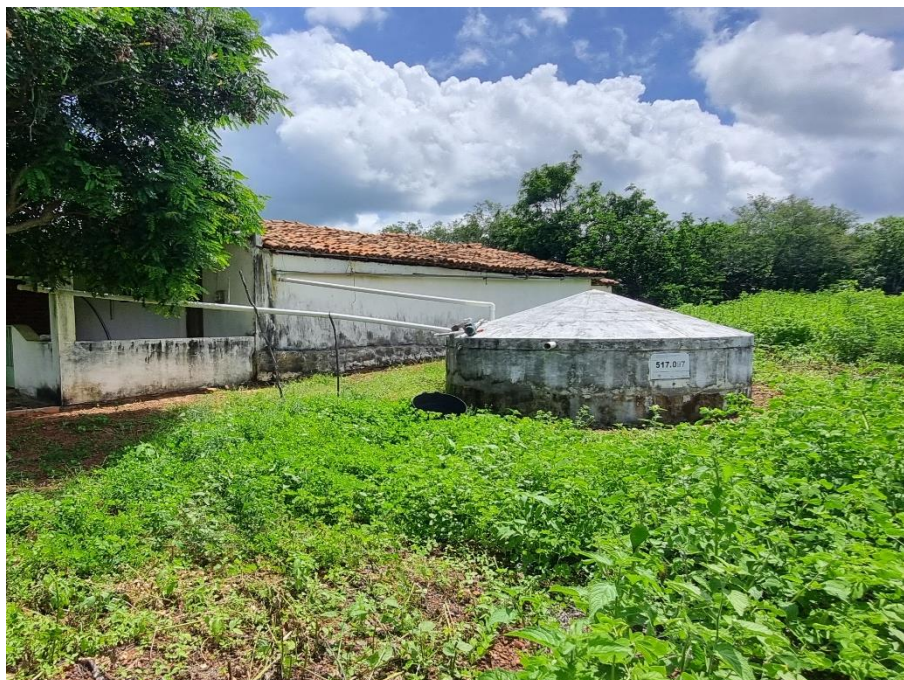
Foto 69: Cisterna da prefeitura de Iraporanga, situada na localidade de Teotônio, município de Iraporanga. Coordenadas: Este – 274.891 ; Norte – 9.447.262.
