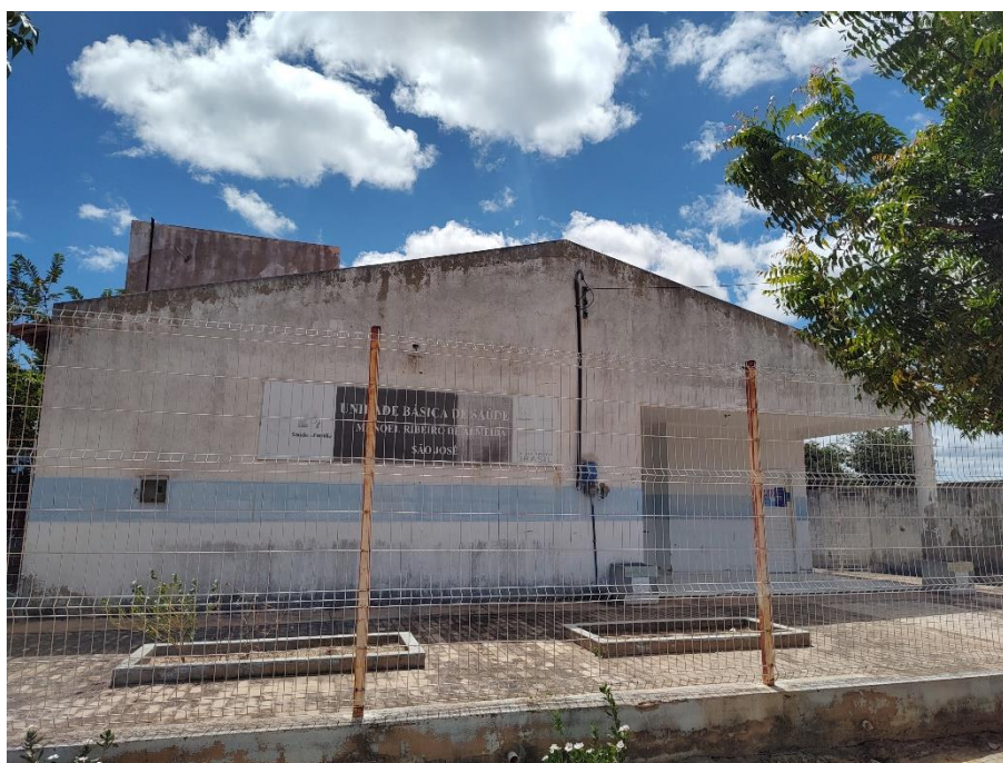
Foto 37: Unidade Básica de Saúde Manoel Ribeiro de Almeida, situada na localidade de São José, Carnaubal. Administrado pelo município de Carnaubal. Coordenadas: Este – 266.707 ; Norte – 9.529.519.
