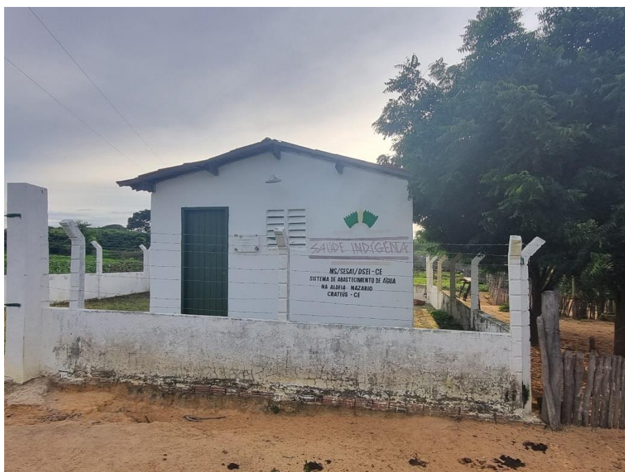
Foto 66: Poço profundo da SISAR, situado na aldeia Nazário, município de Crateús. Coordenadas: Este – 280.913 ; Norte – 9.435.298.
