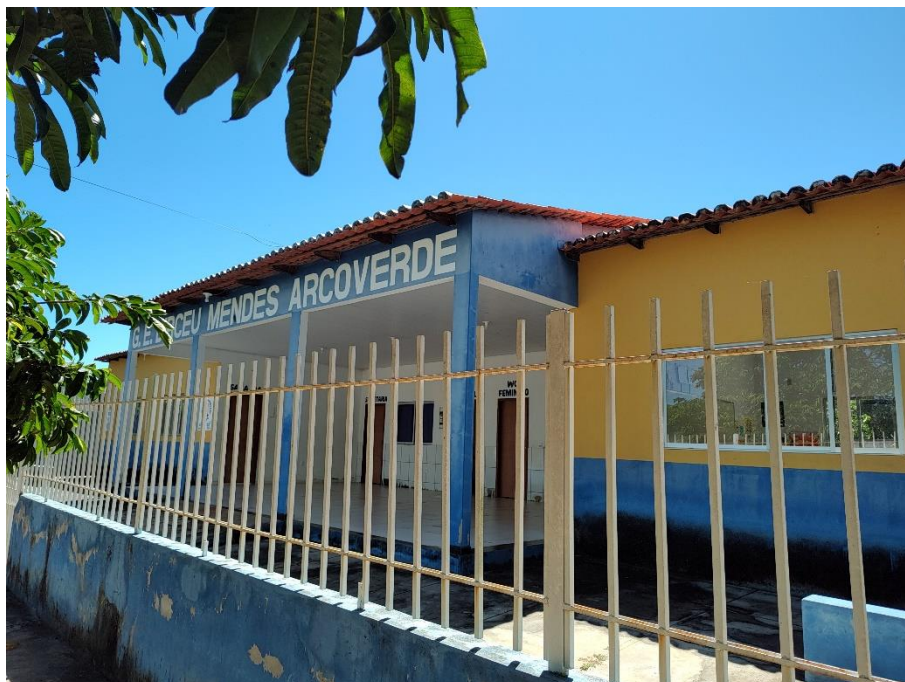
Foto 25: Grupo Escolar Mendes Arcoverde, situada na localidade de Tucuns, Granja. Administrado pelo município de Cocal (PI). Coordenadas: Este – 239.212 ; Norte – 9.622.083.
