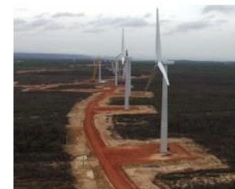
Exemplo de torre de energia eólica em Tianguá.
