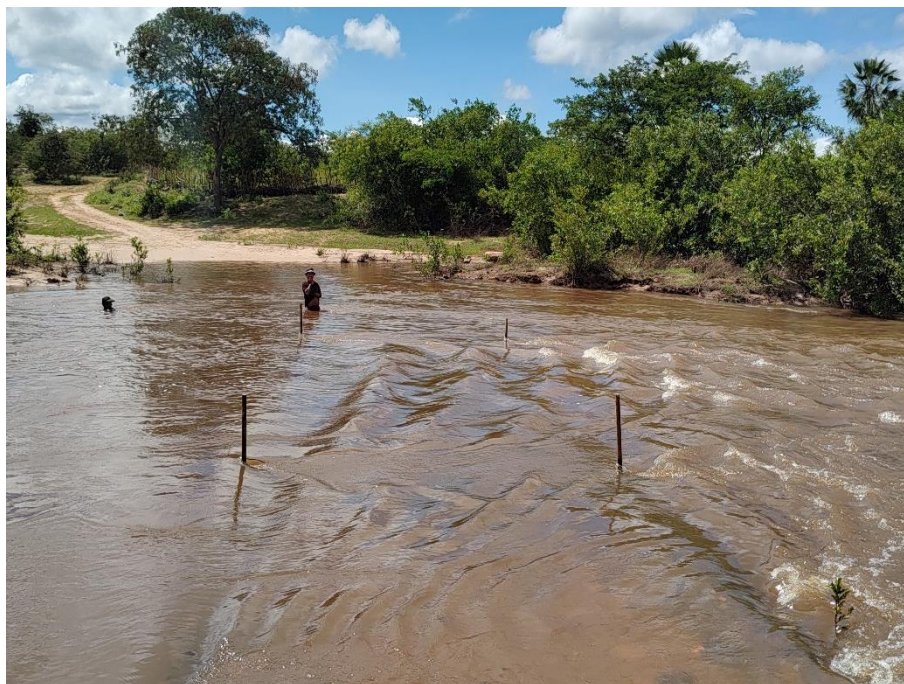
Foto 125: Passagem molhada do rio Macambira, situada na localidade de Barra Velha, município de Poranga. Coordenadas: Este – 261.835 ; Norte – 9.468.041.
