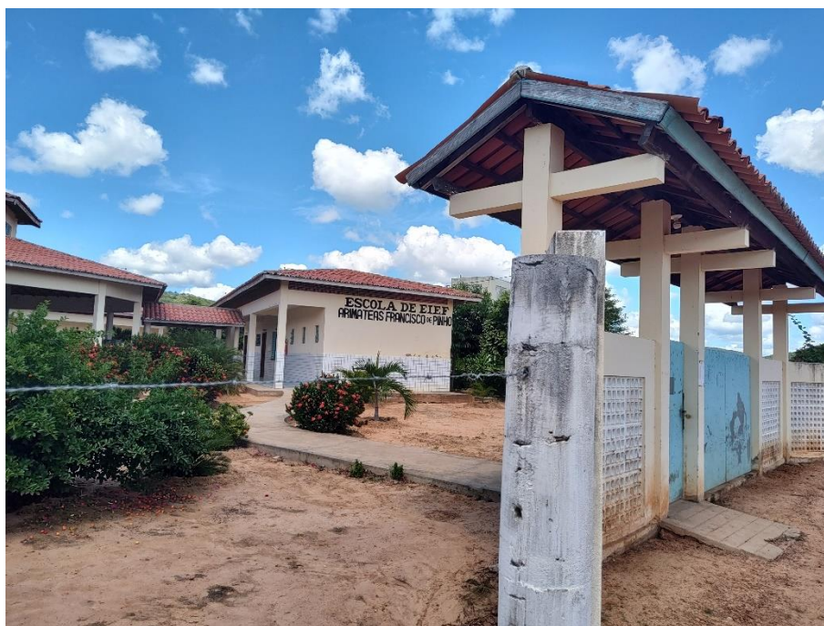
Foto 10: Escola de Ensino Infantil e Fundamental Arimateas Francisco de Pinho, situada no distrito de Macambira, Poranga. Administrada pelo município de Poranga. Coordenadas: Este – 267.328 ; Norte – 9.469.395.
