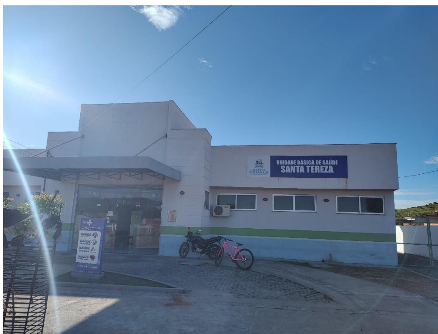
Foto 32: Unidade Básica de Saúde Santa Tereza, situada no distrito de Santa Tereza, Croatá. Administrado pelo município de Croatá. Coordenadas: Este – 270.937 ; Norte – 9.514.920.
