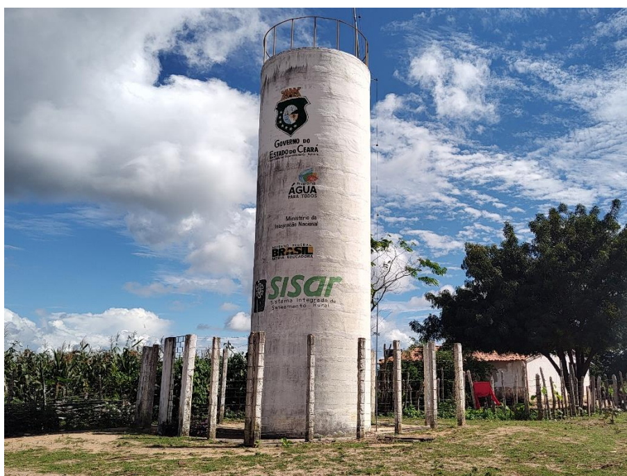
Foto 102: Torre de abastecimento do SISAR, instalada pelo Governo do Ceará, situada na localidade de Assentamento Boa Vista, município de Crateús. Coordenadas: Este – 287.422 ; Norte – 9.400.867.
