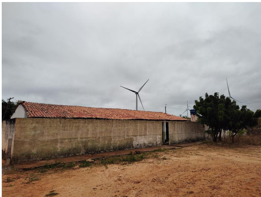
Foto 21: Escola municipal José Parente da Costa, atualmente fechada para reforma, situada na localidade de Ponta da Serra, município de Ubajara. Administrada pelo município de Ubajara. Coordenadas: Este – 257.584 ; Norte – 9.569.577.
