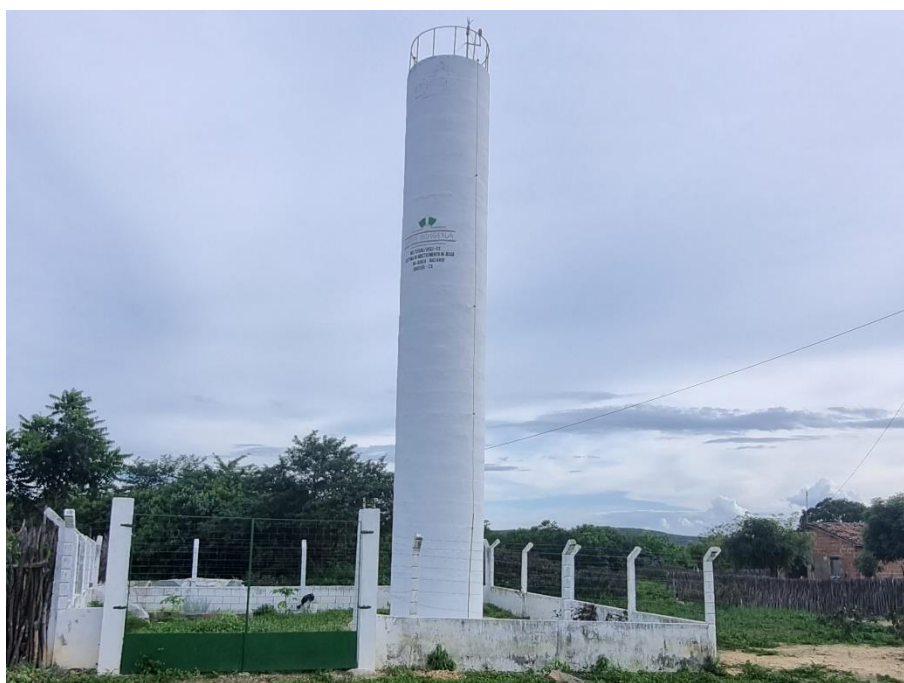
Foto 64: Torre de abastecimento do SISAR, Governo do Ceará, situada na localidade de Mambira, Município de Crateús. Coordenadas: Este – 280.780 ; Norte – 9.435.100.
