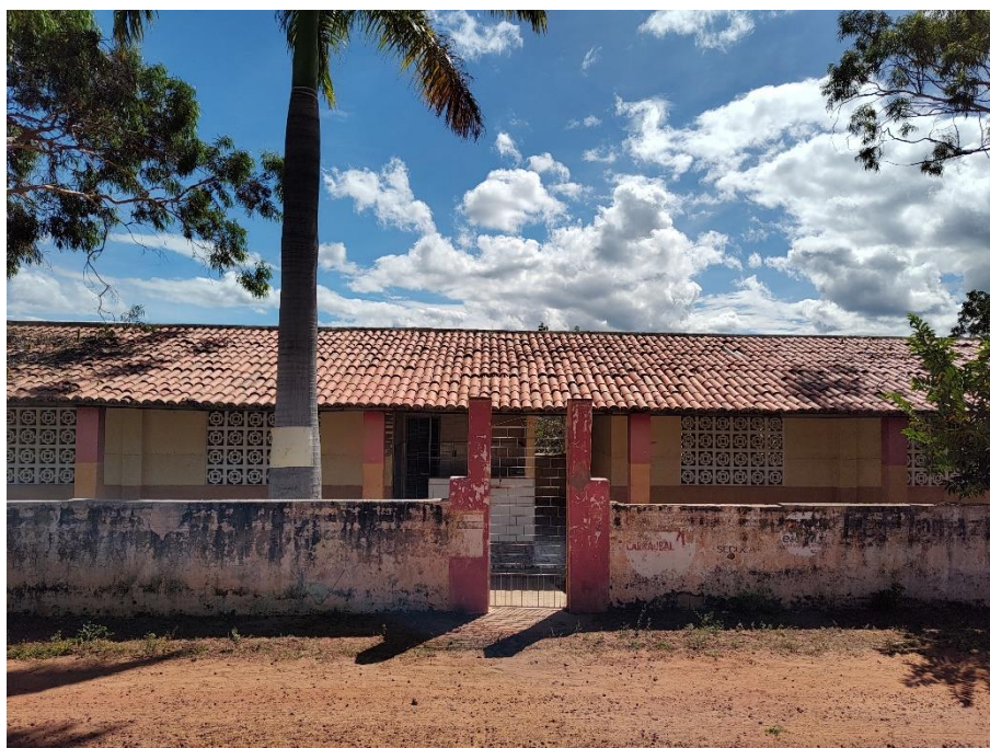
Foto 20: Escola municipal Tomas Bispo de Medeiros, situada na localidade de Jardim, Carnaubal. Administrada pelo município de Carnaubal. Coordenadas: Este – 267.989 ; Norte – 9.543.590.
