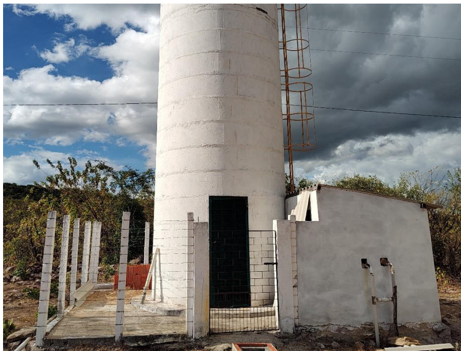
Foto 115: Torre de abastecimento do SISAR, instalada pelo Governo do Ceará, situada na localidade de Três Irmãos, município de Croatá. Coordenadas: Este – 267.290 ; Norte – 9.510.017.
