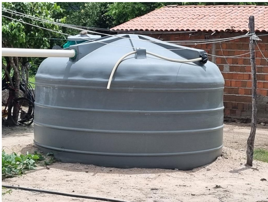
Foto 61: Cisterna do Governo Federal, situada na localidade de Alto Bonito, município de Crateús. Coordenadas: Este – 279.154 ; Norte – 9.442.492.
