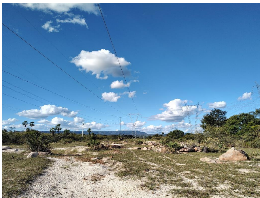
Foto 146: Linhas de alta tensão, situadas na localidade de Cajueirinho, município de Ibiapina. Coordenadas: Este – 252.787 ; Norte – 9.555.117.
