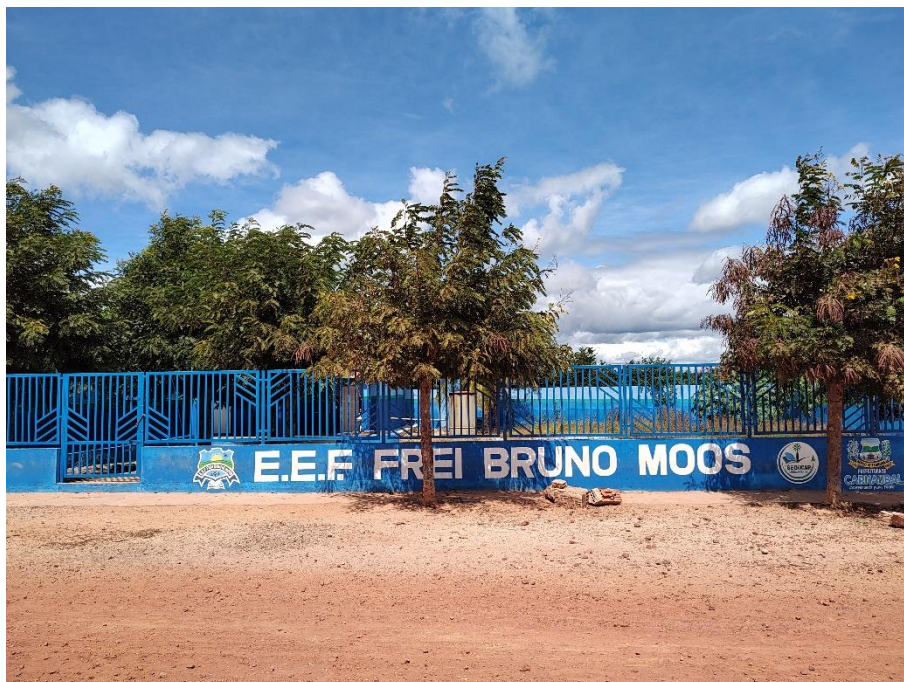
Foto 19: Escola Ensino Fundamental Frei Bruno Moos, situada na localidade de Cocal, Carnaubal. Administrada pelo município de Carnaubal. Coordenadas: Este – 268.798 ; Norte – 9.540.083.
