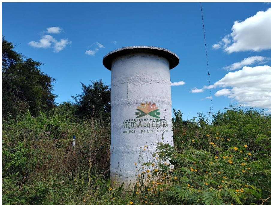
Foto 113: Cisterna da prefeitura de Viçosa do Ceará, situada na localidade de Pirapora, município de Viçosa do Ceará. Coordenadas: Este – 235.384 ; Norte – 9.606.772.
