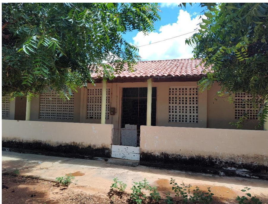
Foto 28: Posto de Saúde, situado no distrito de Macambira, Poranga. Administrado pelo município de Poranga. Coordenadas: Este – 267.325 ; Norte – 9.469.569.
