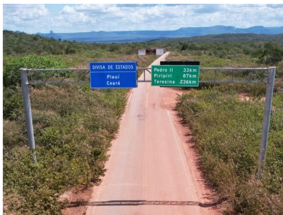
Foto 150: Placa de divisa estadual, situada no distrito de Cachoeira Grande, município de Poranga. Coordenadas: Este – 253.533 ; Norte – 9.494.787.
