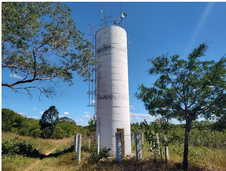
Foto 117: Torre de abastecimento SISAR, instalada pelo Governo do Ceará, situada na localidade de Serra Nova, município de Guaraciaba do Norte. Coordenadas: Este – 264.852 ; Norte – 9.523.456.
