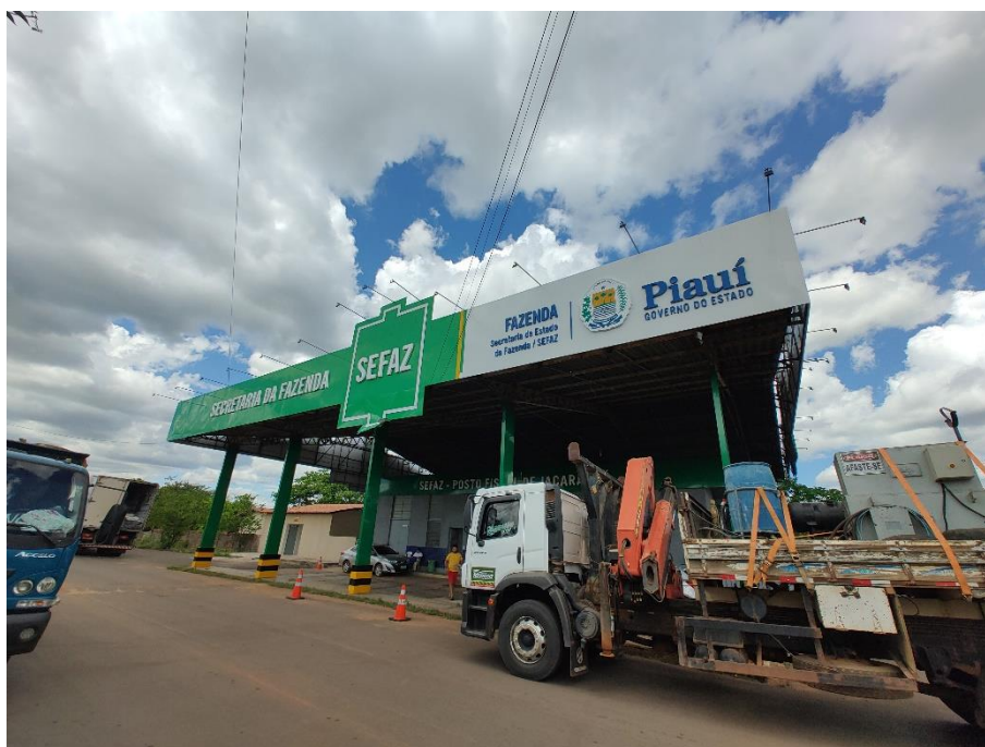
Foto 148: Posto da SEFAZ-PI, situado no município de Cocal. Coordenadas: Este – 230.387 ; Norte – 9.610.654.
