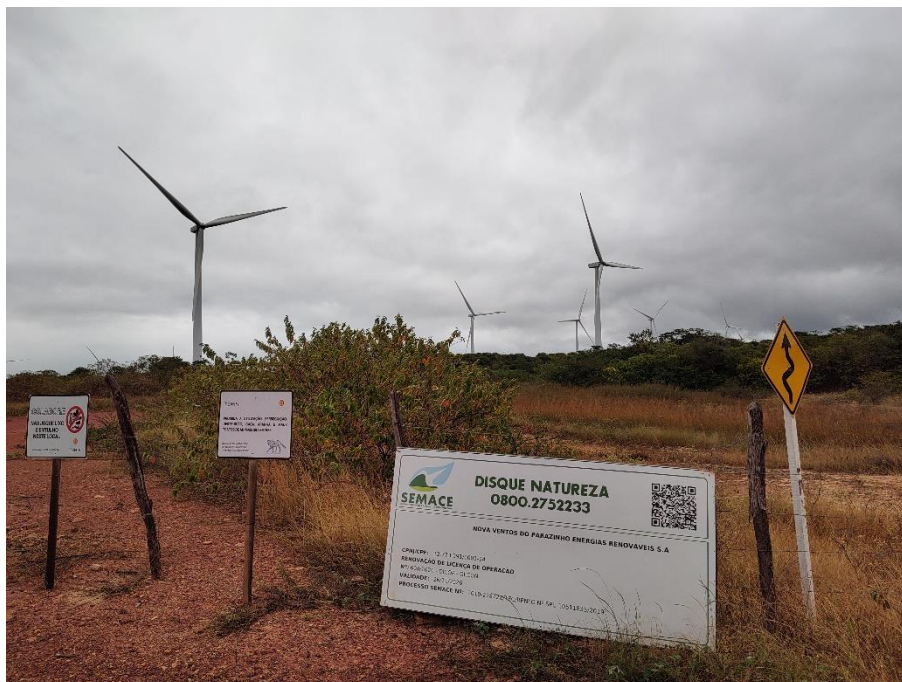
Foto 145: Usina de energia eólica Nova Ventos do Parazinho, licenciada pelo Governo do Ceará, situada na localidade de Ponta da Serra, município de Ubajara. Coordenadas: Este – 257.569 ; Norte – 9.569.673.
