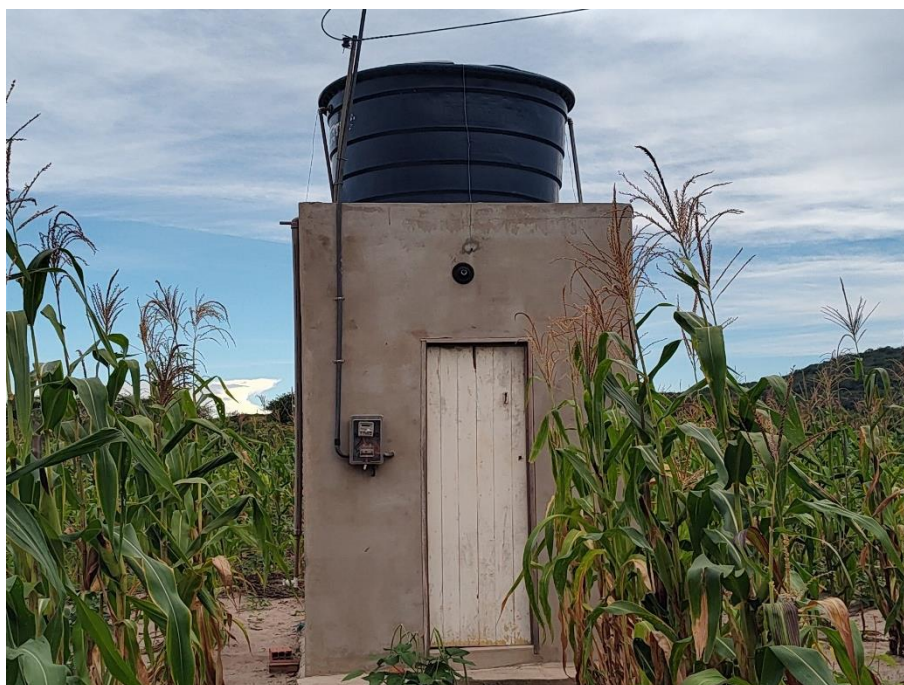
Foto 86: Poço profundo da prefeitura de Poranga, situado na localidade de Sítio Novo, município de Poranga. Coordenadas: Este – 268.683 ; Norte – 9.486.707.
