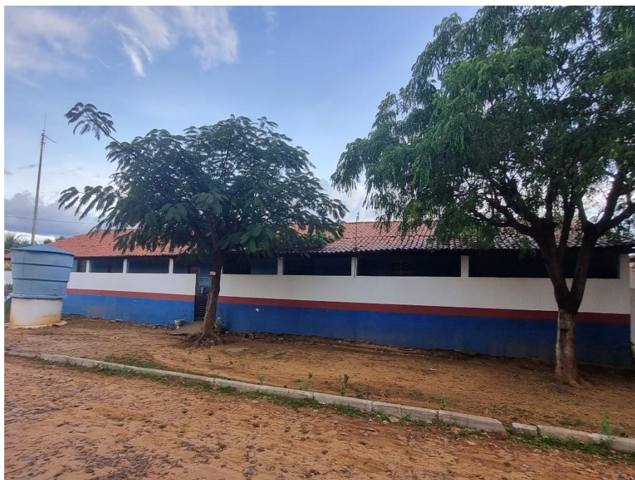
Foto 9: Escola de Ensino Infantil Rosalina Carreiro de Melo, situada na localidade de Arraial, Poranga. Administrada pelo município de Poranga. Coordenadas: Este – 257.220 ; Norte – 9.478.704.
