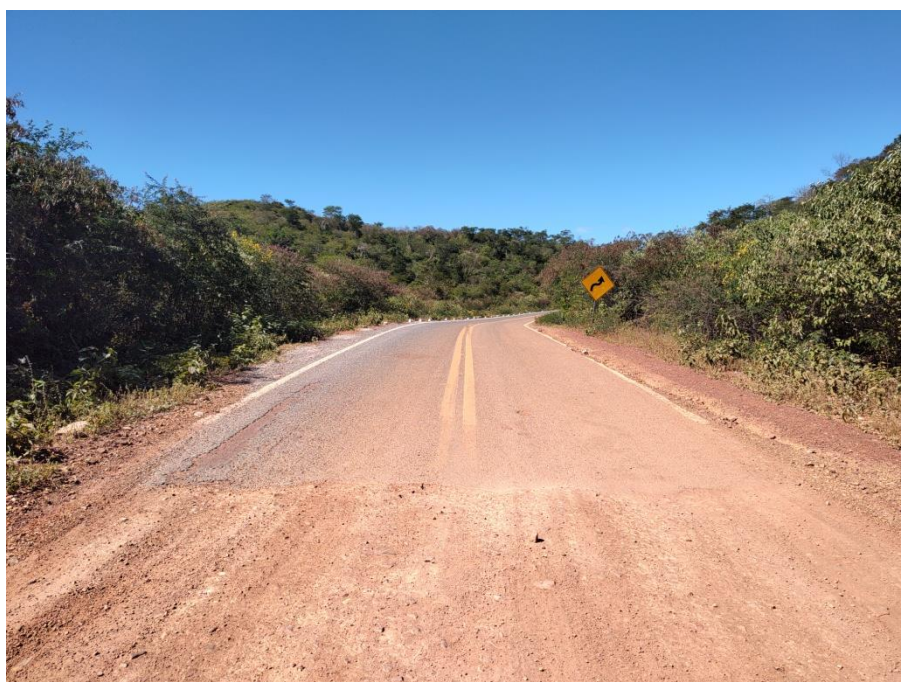
Foto 136: Fim do asfalto na CE 323, início da PI 258 (sem asfalto), situado na localidade de Serra Nova, município de Guaraciaba do Norte. Coordenadas: Este – 264.799 ; Norte – 9.523.683.
