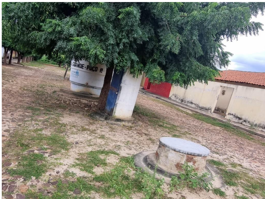
Foto 77: Poço profundo da prefeitura de Poranga instalado pela Companhia de Gestão dos Recursos Hídricos (COGERH), situado no Distrito de Cachoeira Grande, município de Poranga. Coordenadas: Este – 256.602 ; Norte – 9.491.512.
