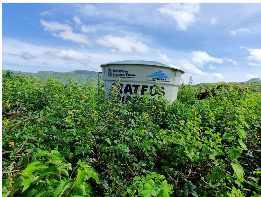
Foto 59: Cisterna da prefeitura de Crateús implantada pelo Governo do Ceará, situada na localidade de Alto Bonito, município de Crateús. Coordenadas: Este – 281.942 ; Norte – 9.442.256.
