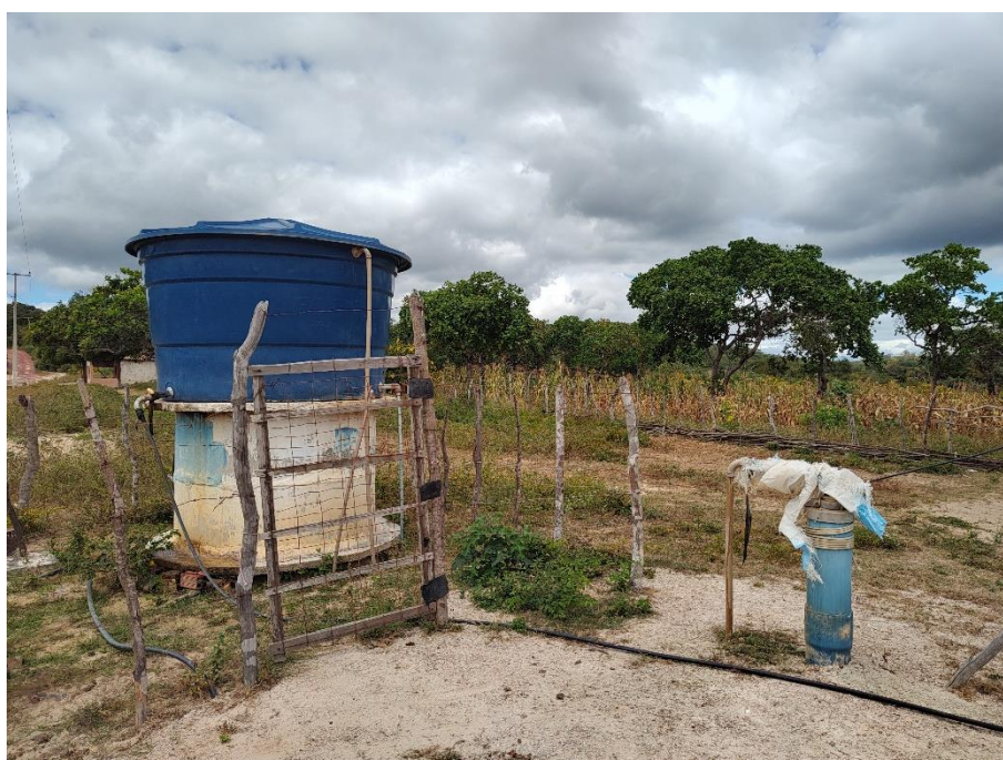
Foto 112: Poço profundo da prefeitura de Viçosa do Ceará, situado na localidade de Santa Maria, município de Viçosa do Ceará. Coordenadas: Este – 251.780 ; Norte – 9.588.828.
