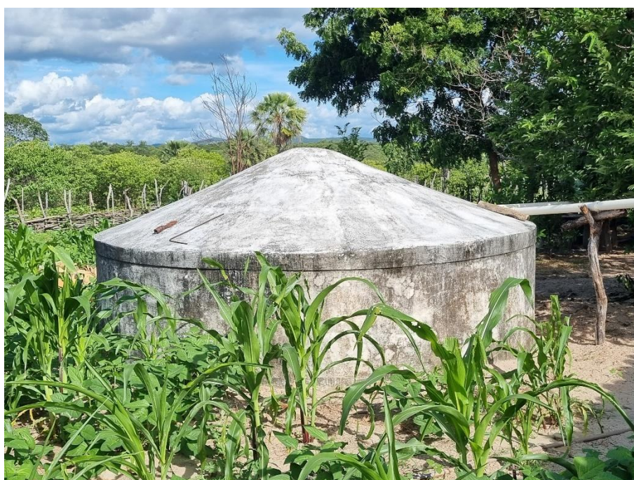
Foto 76: Cisterna da prefeitura de Ipueiras, situada na localidade de Mel, município de Ipueiras. Coordenadas: Este – 264.174 ; Norte – 9.493.466.
