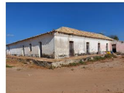
Casarão de Pedras na localidade de Canindé Grande, município de Croatá.
