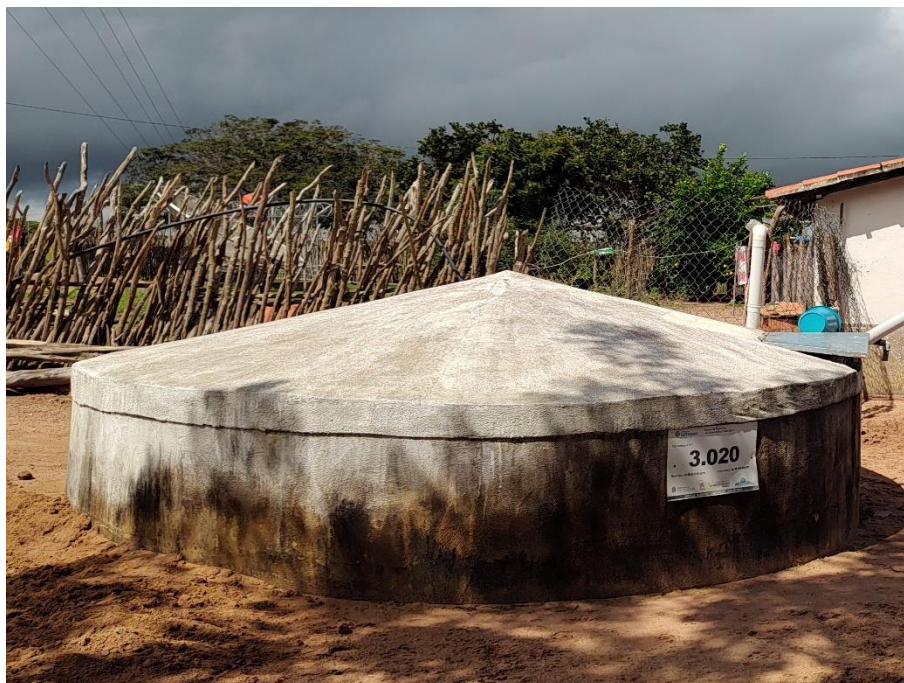
Foto 100: Cisterna da prefeitura de Crateús, situada na localidade de Cedro, município de Crateús. Coordenadas: Este – 285.112 ; Norte – 9.406.781.
