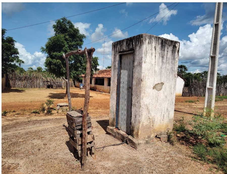
Foto 88: Poço profundo da prefeitura de Poranga, situado na localidade de Pitombeira, município de Poranga. Coordenadas: Este – 254.612 ; Norte – 9.474.783.
